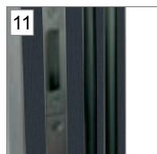
Przegroda termiczna, dwie uszczelki w ościeżnicy
